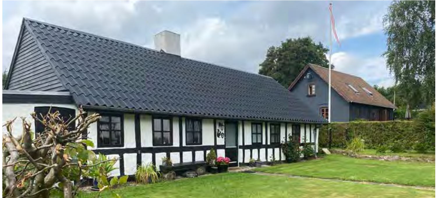
Billedet viser et bindingsværkshus i Addit.
